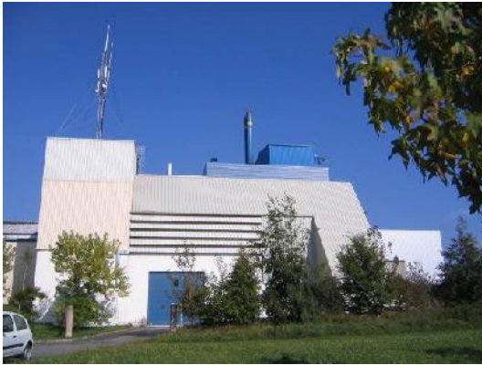
Usine d'incinération de Concarneau
