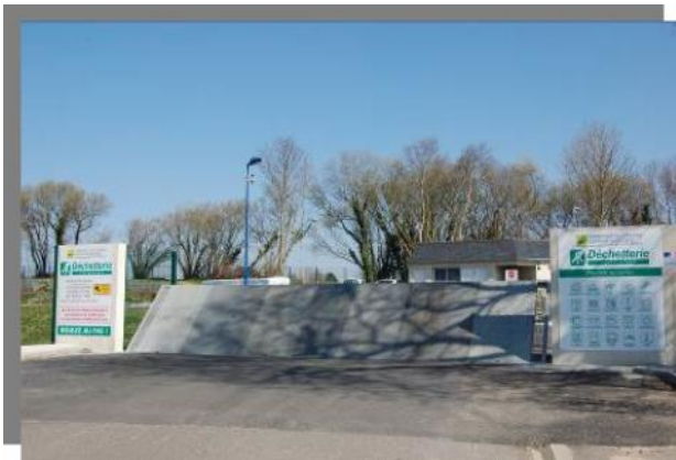
Accès de la déchèterie de Lannugat par un pont levis
