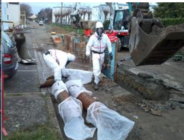
Chantier Rue Pierre Pernès
