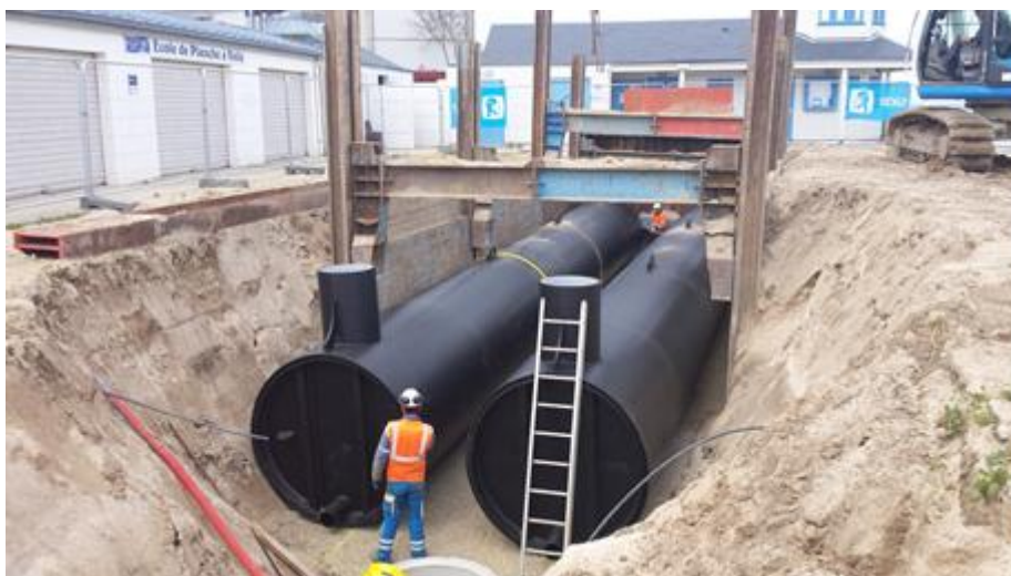
Ouvrage de sécurisation aux Sables Blancs
