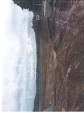
Lagune N°1 La plus grande qui peut accueillir 6000m 3 de mélange eau/sédiments.
