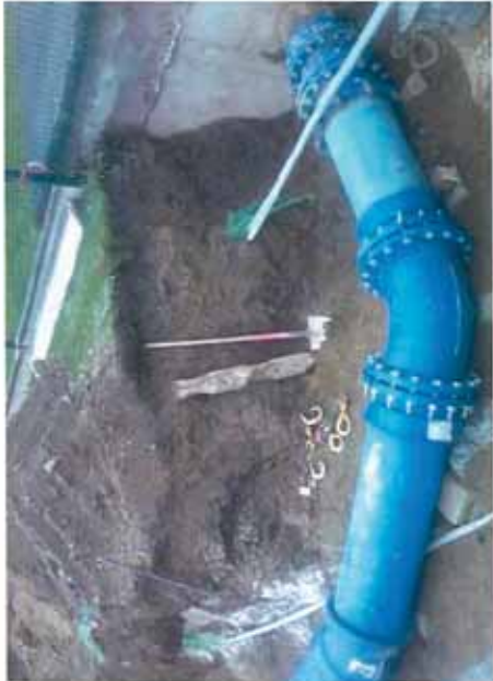
Renouvellement de la canalisation d'eaux brutes entre le captage d'eaux superficielles de Kertry et l'usine de potabilisation de Kervignac (février 2019)
