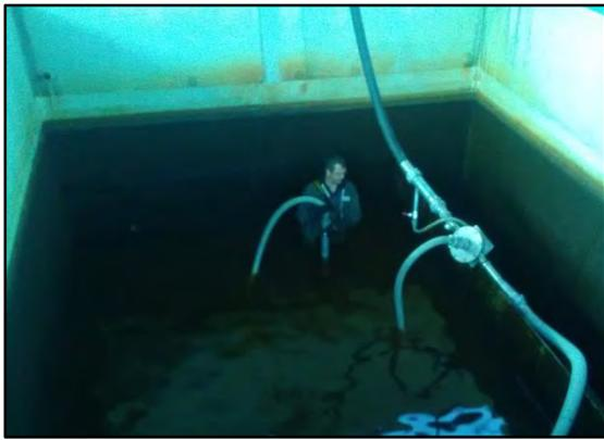
Figure 15 : Extraction du sable par aspiration à l'aide d'un hydroéjecteur.
