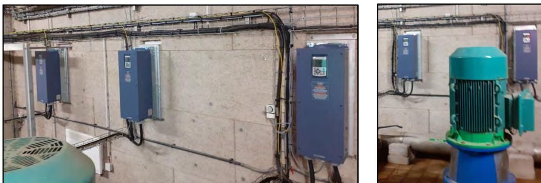
Figure 14 : Variateurs de fréquence dédiée aux applications de pompage
