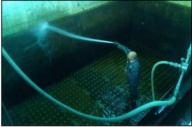
Figure 16 Rinçage d'un filtre.
