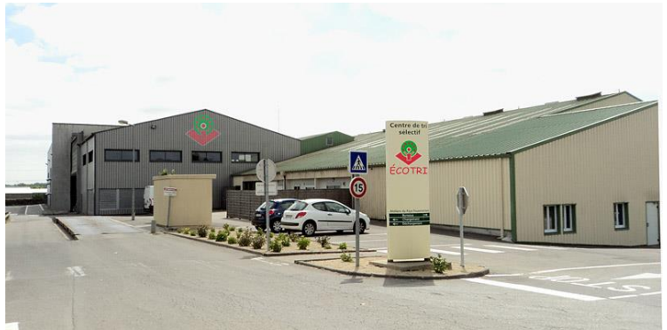
Centre de tri de Fouesnant
