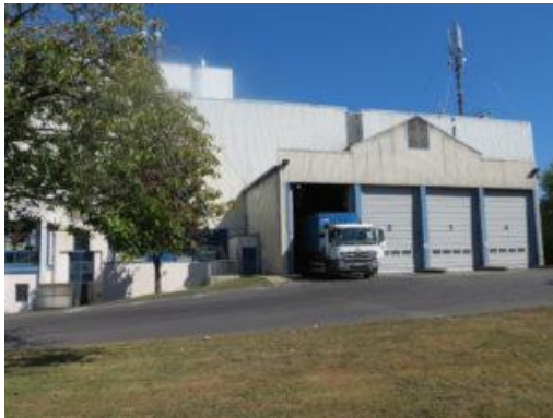
Usine de valorisation énergétique de Concarneau
