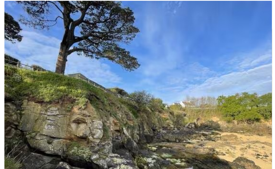
Pors Melen, sentier dévié par l'érosion depuis 2024 (©Ouest-France)
