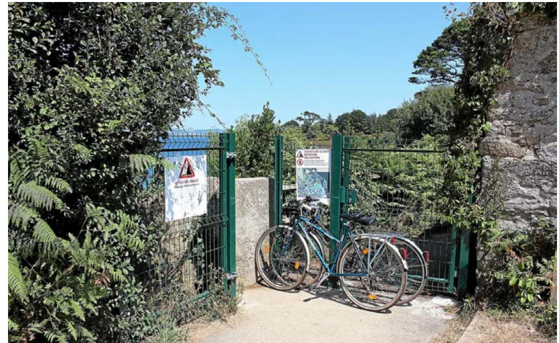
Sentier dévié par l'érosion depuis 2024 au niveau de Porz Melen (©Ouest France)
