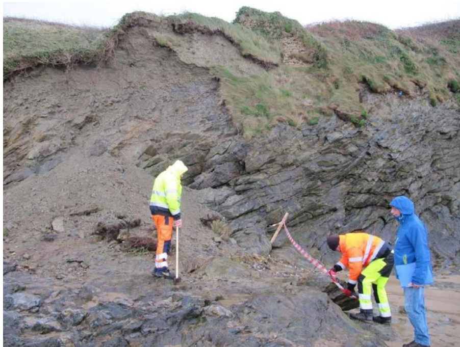
Eboulement de la falaise de Lanévry, 01.2026 (©Ouest France)
