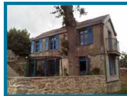
>>> Ravalement avant travaux
