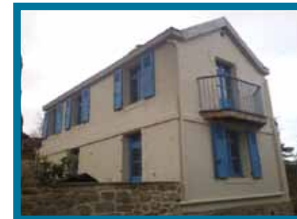
>>> Ravalement après travaux
