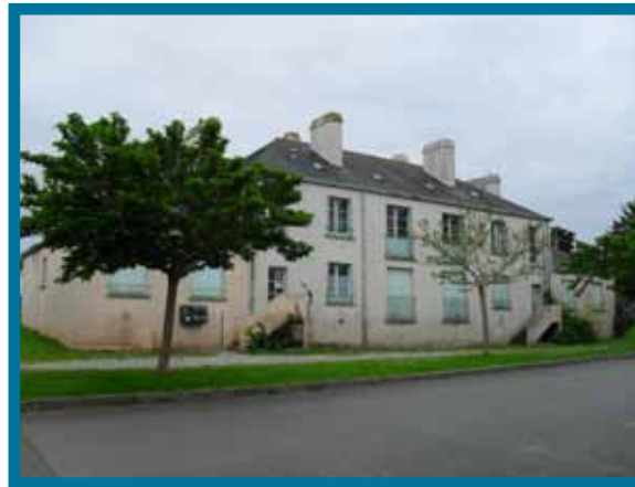
>>> Opération rue Jules Verne à Douarnenez, avant travaux
