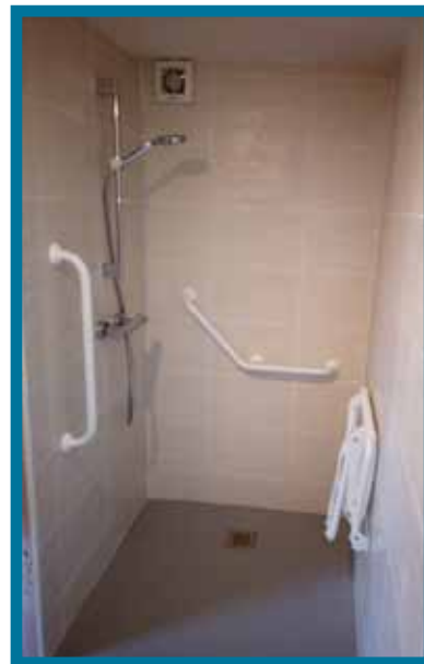
>>> Salle de bain après travaux
