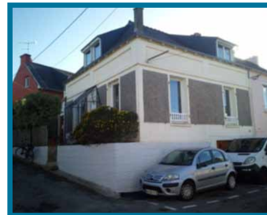
>>> Isolation avant travaux
