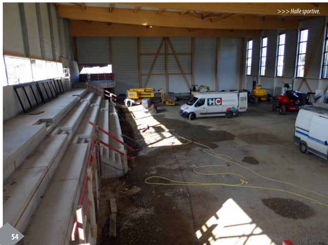
>>> Chantier du Centre aquatique.
